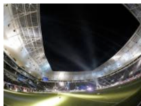
Nach Signal Iduna Park und Commerzbank-Arena stattete Weckbacher nun auch das neue Stadion von, die Rhein-Neckar-Arena, mit einer Schließanlage aus. Foto: Archiv
