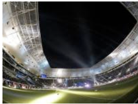
Nach Signal Iduna Park und Commerzbank-Arena stattete Weckbacher nun auch das neue Stadion von, die Rhein-Neckar-Arena, mit einer Schließanlage aus. Foto: Archiv
