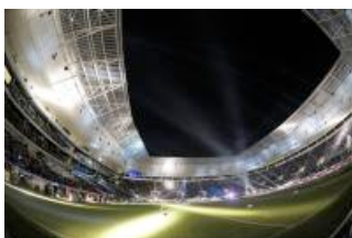
Nach Signal Iduna Park und Commerzbank-Arena stattete Weckbacher nun auch das neue Stadion von, die Rhein-Neckar-Arena, mit einer Schließanlage aus. Foto: Archiv
