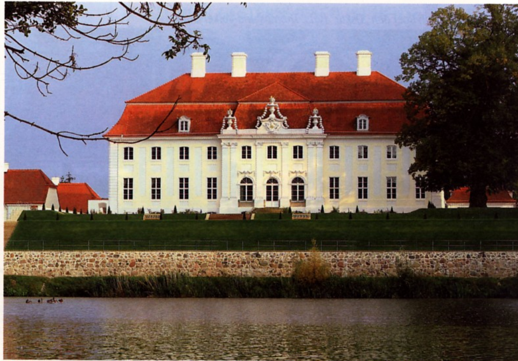
Hinter der prachtvollen Fassade des Barockschlosses in Meseberg steckt Sicherheitstechnik aus Dortmund.
